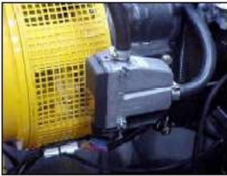
Sistema de resistencias insertadas en el bloque motor que dotan al mismo de una Tª adecuada para facilitar el arranque del Grupo Electrónico
